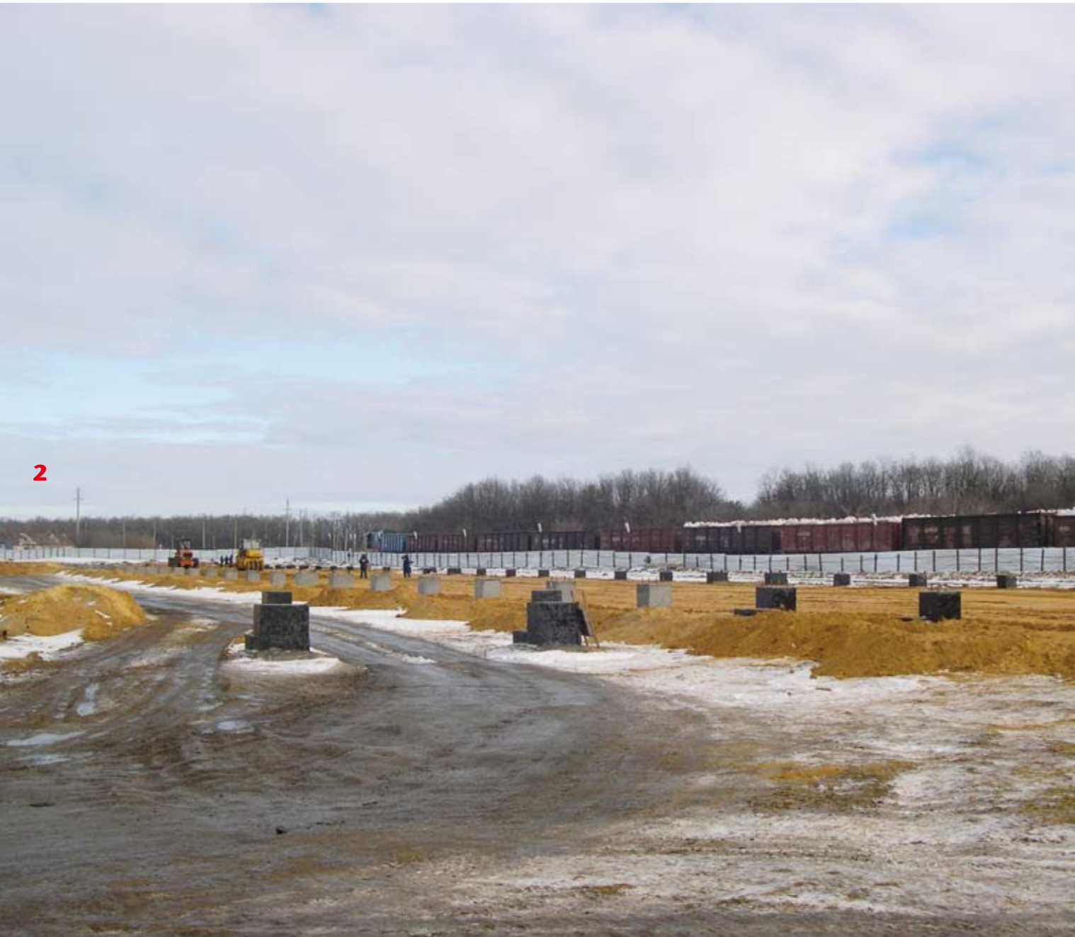
Fundamentarbeiten Halle Закладка фундамента под производственный корпус
